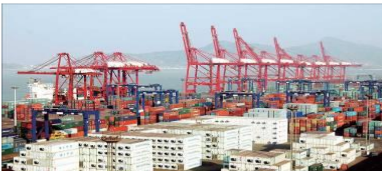
Figura 1: Pátio de operações do Porto de Xangai . Fonte: gigantes do mundo, 2012.
